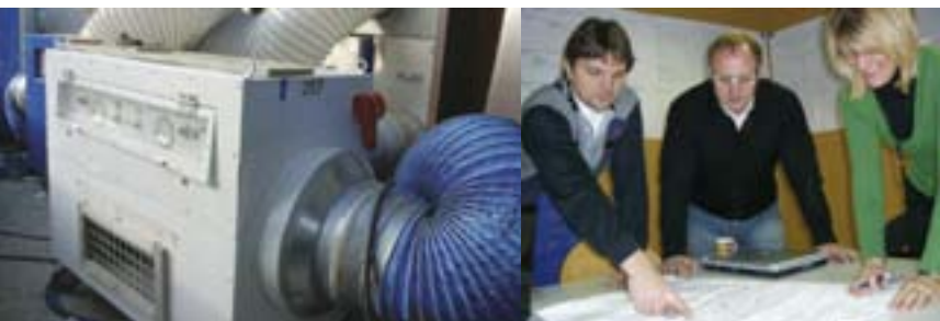
Links: Keine Asbestsanierung ohne strikte Schwarz-weiß-Trennung sowie die Luftver- und Entsorgung über entsprechende Aggregate und flexible Rohre. Rechts: Bauleiter Jens Schmidt, Waldemar Wojnowski und Gutachterin Carla Klensk bei der Feinabstimmung im Detail. Unten: „Wahrzeichen“ der Musikschule ist die vor der Aula platzierte Beton-Skulptur.
