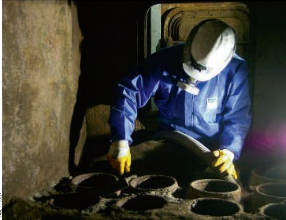
Die Entfernung von Gichtstaub in den Filterkammern setzt hochtoxische Stäube frei.
