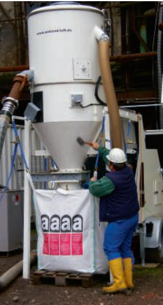
Gefahrstoffe werden mittels spezieller Hochleistungsindustriesauger der Klasse ‚H‘ abgesaugt und entsorgungsgerecht verpackt.
